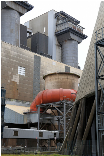
Kraftwerk Niederaußem: Kesselhaus Block G, Rauchgasleerzugkanal, Ansicht von Norden; Foto: 15.08.2023 Fotograf/Urheber: Dr. Norbert Gilson
