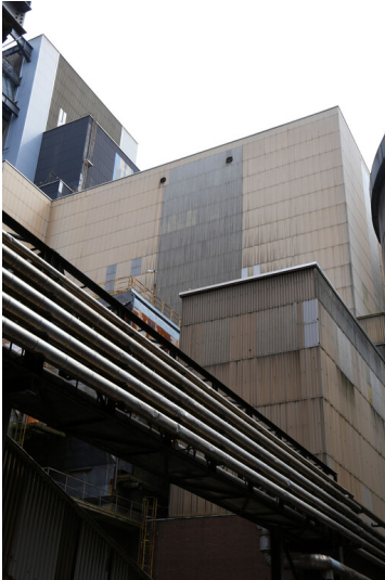
Kraftwerk Niederaußem: Kesselhaus Block F, Ansicht von Nordwesten; Foto: 15.08.2023 Fotograf/Urheber: Dr. Norbert Gilson
