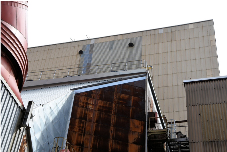
Kraftwerk Niederaußem: Kesselhaus Block D, Ansicht von Nordwesten; Foto: 15.08.2023 Fotograf/Urheber: Dr. Norbert Gilson
