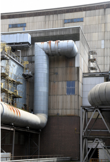
Kraftwerk Niederaußem: Kesselhaus Block C1/C2, Ansicht von Nordwesten; Foto: 15.08.2023 Fotograf/Urheber: Dr. Norbert Gilson
