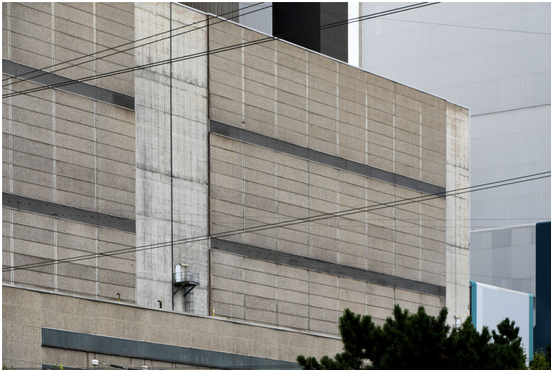
Kraftwerk Niederaußem: Schwerbau Block H, Ansicht von Süden; Foto: 15.08.2023 Fotograf/Urheber: Dr. Norbert Gilson
