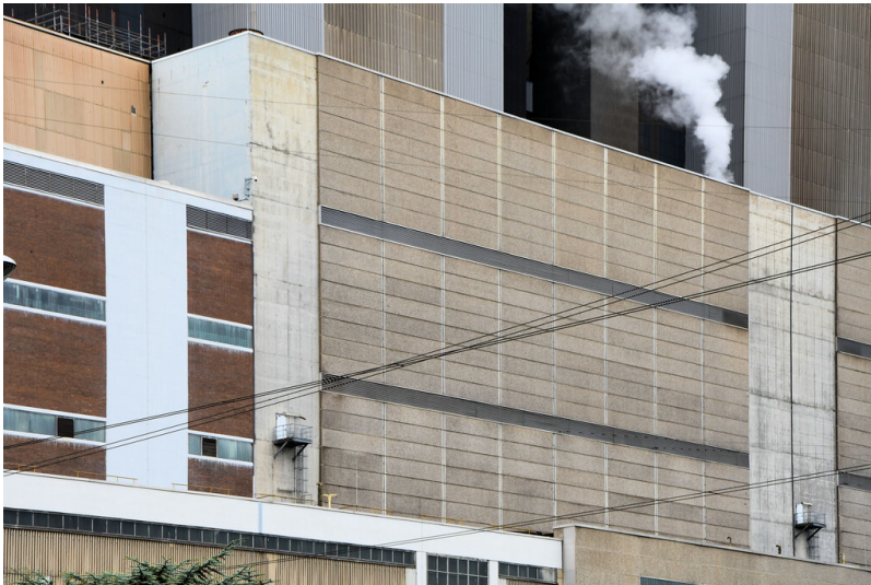
Kraftwerk Niederaußem: Schwerbau Block G, Ansicht von Süden; Foto: 15.08.2023 Fotograf/Urheber: Dr. Norbert Gilson
