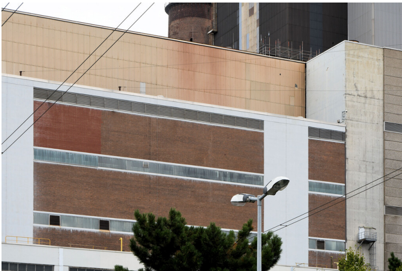
Kraftwerk Niederaußem: Schwerbau Block F, Ansicht von Süden; Foto: 15.08.2023 Fotograf/Urheber: Dr. Norbert Gilson
