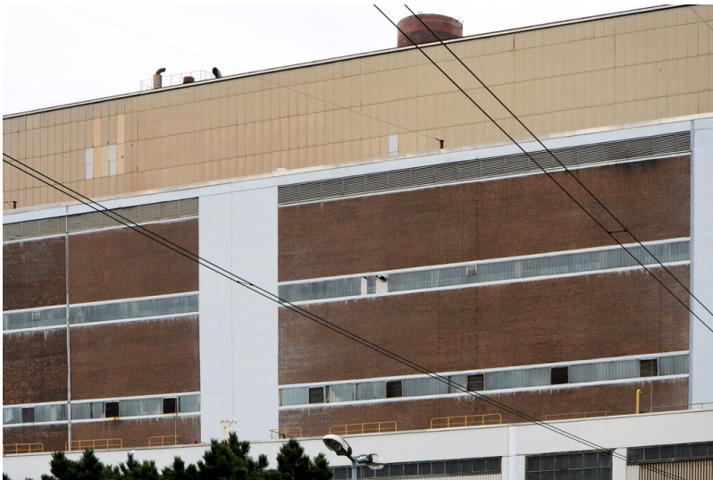
Kraftwerk Niederaußem: Schwerbau Block E, Ansicht von Südosten; Foto: 15.08.2023 Fotograf/Urheber: Dr. Norbert Gilson
