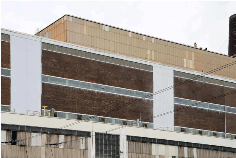
Kraftwerk Niederaußem: Schwerbau Block D, Ansicht von Süden; Foto: 15.08.2023 Fotograf/Urheber: Dr. Norbert Gilson
