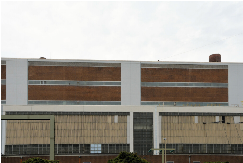
Kraftwerk Niederaußem: Schwerbau Block C1/C2, Ansicht von Südosten; Foto: 15.08.2023 Fotograf/Urheber: Dr. Norbert Gilson
