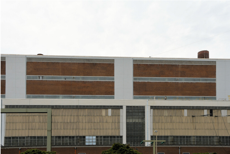
Kraftwerk Niederaußem: Schwerbau Block C1/C2, Ansicht von Südosten; Foto: 15.08.2023 Fotograf/Urheber: Dr. Norbert Gilson
