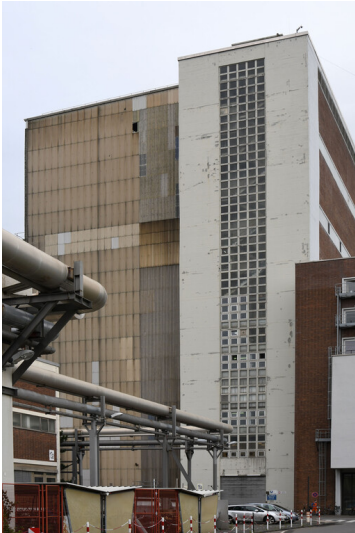
Kraftwerk Niederaußem: Schwerbau Blöcke A/B, Treppenhausvorbau vor Block A, Ansicht von Südwesten; Foto: 15.08.2023 Fotograf/Urheber: Dr. Norbert Gilson
