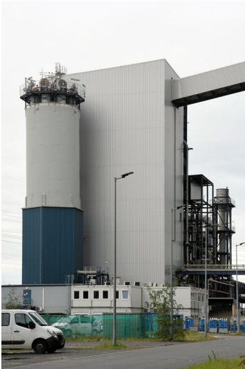
Kraftwerk Niederaußem: WTA-Anlage, Ansicht von Norden; Foto: 15.08.2023 Fotograf/Urheber: Dr. Norbert Gilson
