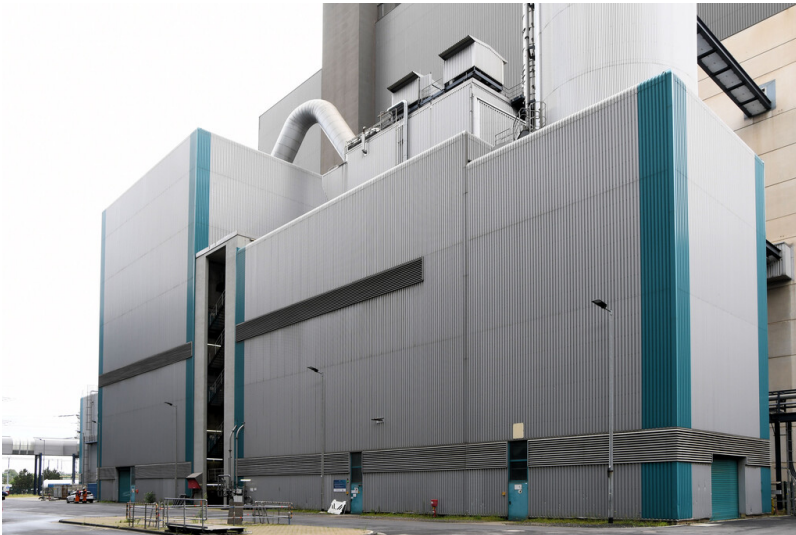
Kraftwerk Niederaußem: Pilotrocknungsanlage, Ansicht von Nordosten; Foto: 15.08.2023 Fotograf/Urheber: Dr. Norbert Gilson
