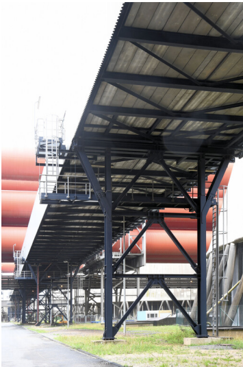
Kraftwerk Niederaußem: Bekohlungsbandbrücke vom Kohleverteilerbunker zum Kesselhaus Block K, Ansicht von Nordosten; Foto: 15.08.2023 Fotograf/Urheber: Dr. Norbert Gilson
