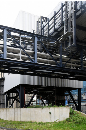
Kraftwerk Niederaußem: Kohleecturm K, Ansicht von Westen; Foto: 17.08.2023 Fotograf/Urheber: Dr. Norbert Gilson
