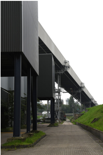
Kraftwerk Niederaußem: Bandbrücke zum Kohleverteilbunker, Ansicht von Nordosten; Foto: 17.08.2023 Fotograf/Urheber: Dr. Norbert Gilson
