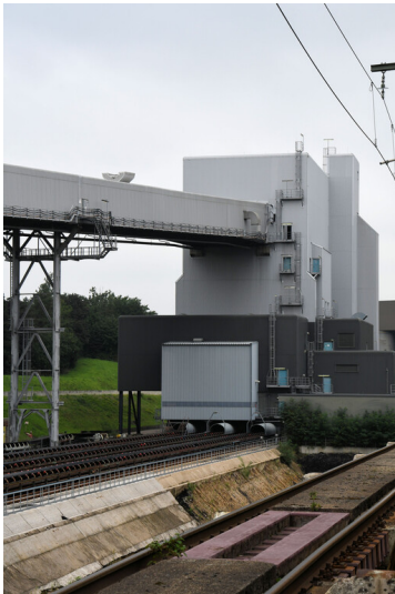
Kraftwerk Niederaußem: Kohleverteilbunker, Einführung des Kohlebandes vom Kohlebunker Fortuna, Ansicht von Südwesten; Foto: 17.08.2023 Fotograf/Urheber: Dr. Norbert Gilson
