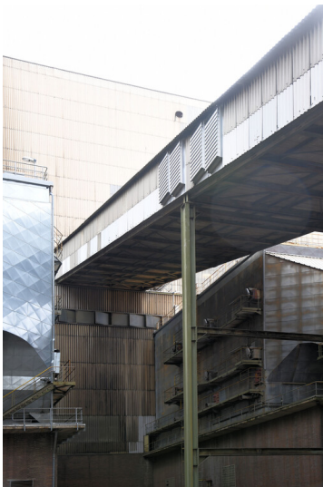
Kraftwerk Niederaußem: Bekohlungsweg zu Block F, Einführung in das Kesselhaus Block F, Ansicht von Norden; Foto: 15.08.2023 Fotograf/Urheber: Dr. Norbert Gilson
