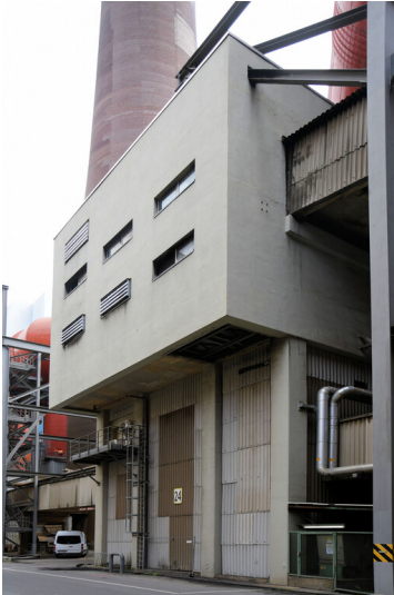
Kraftwerk Niederaußem: Verteilerstation 3, Ansicht von Westen; Foto: 15.08.2023 Fotograf/Urheber: Dr. Norbert Gilson
