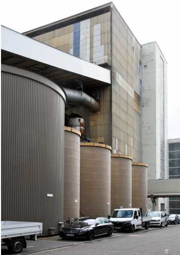
Kraftwerk Niederaußem: Bekohlungsweg Schwerbau Block A, Ansicht von Nordwesten; Foto: 15.08.2023 Fotograf/Urheber: Dr. Norbert Gilson
