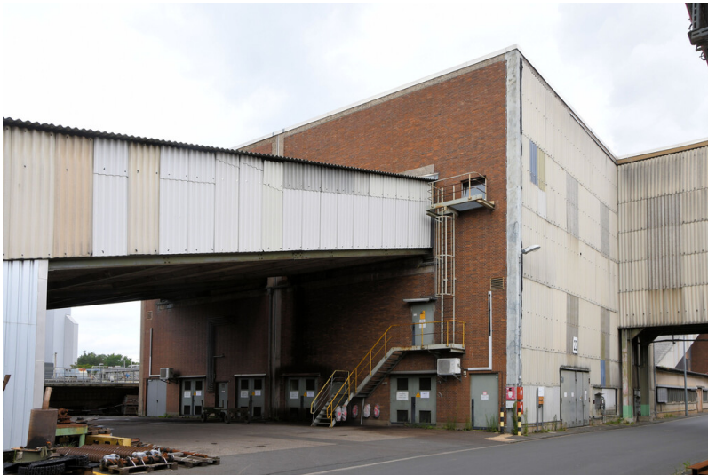
Kraftwerk Niederaußem: Brecherei, Ansicht von Südwesten; Foto: 15.08.2023 Fotograf/Urheber: Dr. Norbert Gilson
