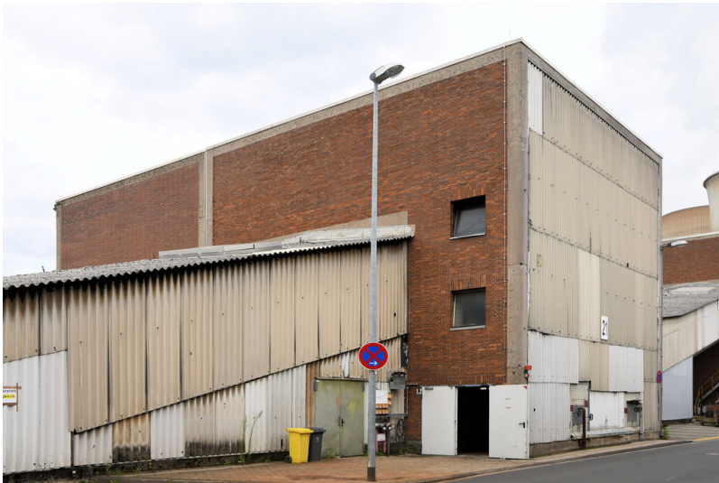
Kraftwerk Niederaußem: Eisenausscheidung, Ansicht von Südwesten; Foto: 15.08.2023 Fotograf/Urheber: Dr. Norbert Gilson
