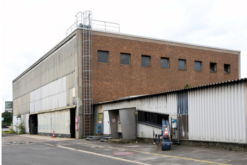
Kraftwerk Niederaußem: Verteilerstation I, Ansicht von Osten; Foto: 15.08.2023 Fotograf/Urheber: Dr. Norbert Gilson
