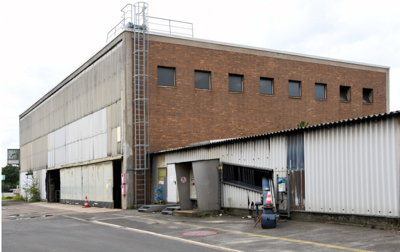
Kraftwerk Niederaußem: Verteilerstation I, Ansicht von Osten; Foto: 15.08.2023 Fotograf/Urheber: Dr. Norbert Gilson
