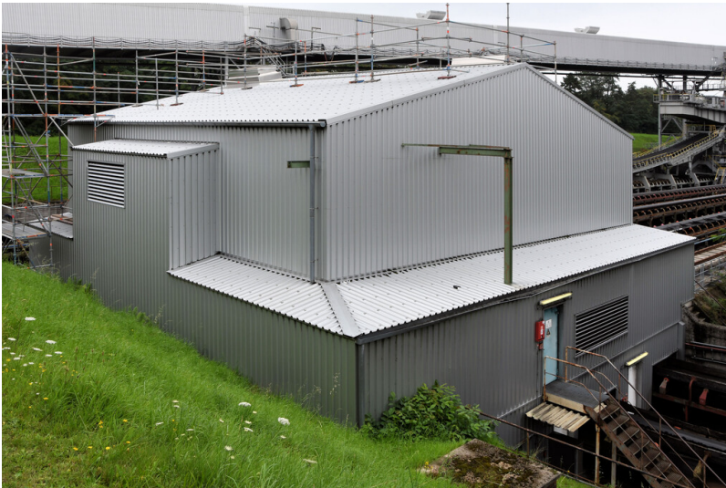
Kraftwerk Niederaußem: Kohleecturm 1, Ansicht von Süden; Foto: 17.08.2023 Fotograf/Urheber: Dr. Norbert Gilson
