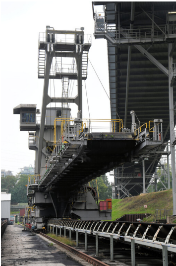
Kraftwerk Niederaußem: Bandschleifenwagen 977, Abwurfausleger, Ansicht von Nordosten; Foto: 17.08.2023 Fotograf/Urheber: Dr. Norbert Gilson
