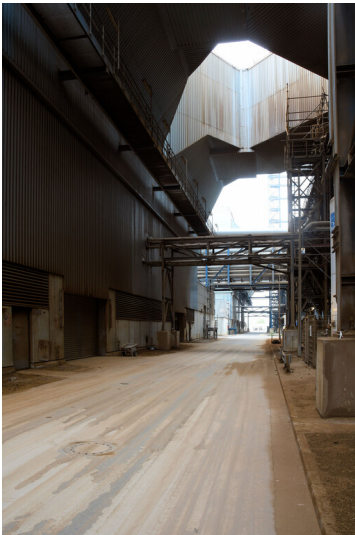
Kraftwerk Neurath (Neuanlage): E-Filter-Weg, Ansicht von Westen; Foto: 23.10.2023 Fotograf/Urheber: Dr. Norbert Gilson
