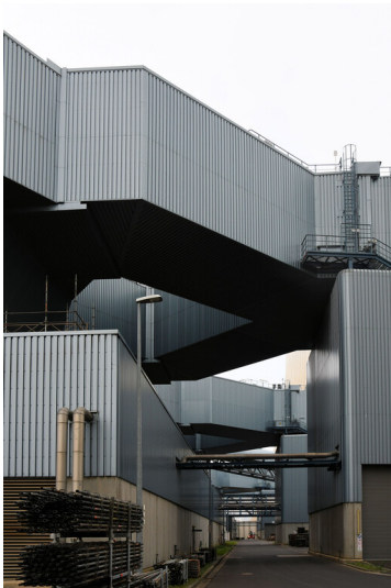
Kraftwerk Neurath (Neuanlage): Saugzugweg, Ansicht von Osten; Foto: 23.10.2023 Fotograf/Urheber: Dr. Norbert Gilson
