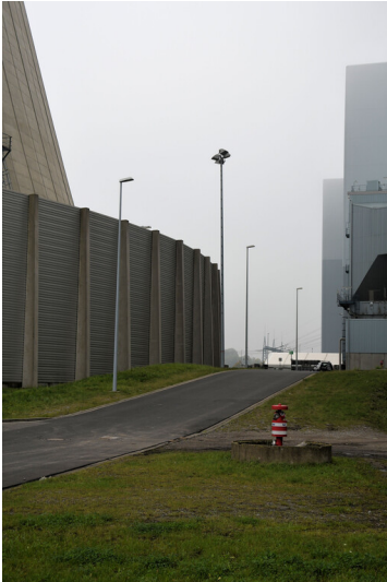
Kraftwerk Neurath (Neuanlage): Block-G-Straße, in Höhe Abzweig von der Nordstraße, Ansicht von Norden; Foto: 23.10.2023 Fotograf/Urheber: Dr. Norbert Gilson
