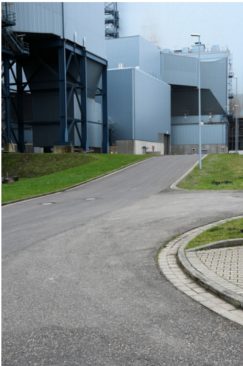
Kraftwerk Neurath (Neuanlage): Block-F-Straße, in Höhe Abzweig von der Nordstraße, Ansicht von Norden; Foto: 23.10.2023 Fotograf/Urheber: Dr. Norbert Gilson
