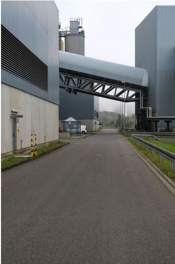
Kraftwerk Neurath (Neuanlage): Nordstraße, in Höhe Absorber-/Pumpenhaus G, Ansicht von Osten; Foto: 23.10.2023 Fotograf/Urheber: Dr. Norbert Gilson
