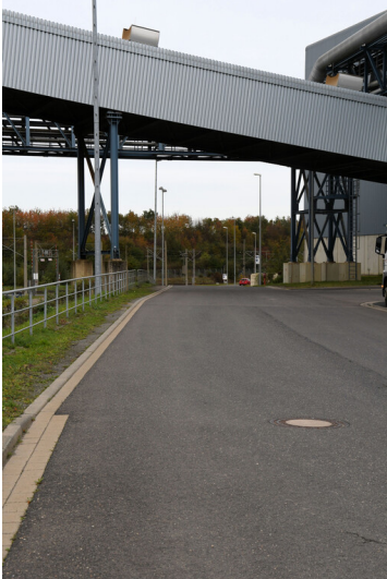
Kraftwerk Neurath (Neuanlage): Weststraße, Ansicht von Süden; Foto: 23.10.2023 Fotograf/Urheber: Dr. Norbert Gilson
