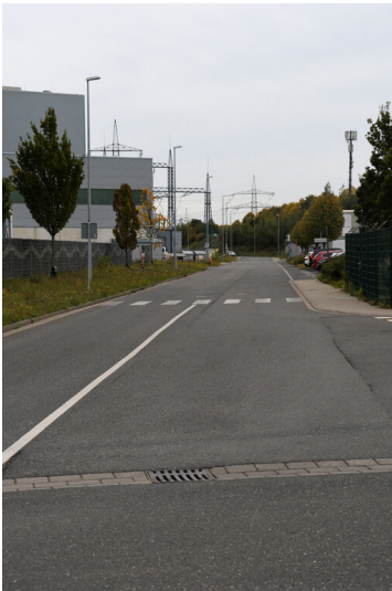
Kraftwerk Neurath (Neuanlage): Südstraße, Ansicht von Westen; Foto: 23.10.2023 Fotograf/Urheber: Dr. Norbert Gilson
