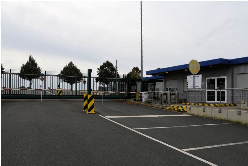
Kraftwerk Neurath: Zufahrtsstraße Pförtner 1, Einfahrtsbereich von der L 375 aus, Ansicht von Nordosten; Foto: 23.10.2023 Fotograf/Urheber: Dr. Norbert Gilson
