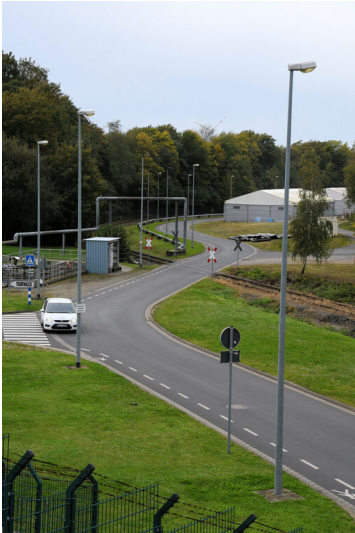
Kraftwerk Neurath: Kiesgrubenstraße, von der Altanlage kommend kurz vor Erreichen der Neuanlage, Ansicht von Nordosten; Foto: 23.10.2023 Fotograf/Urheber: Dr. Norbert Gilson
