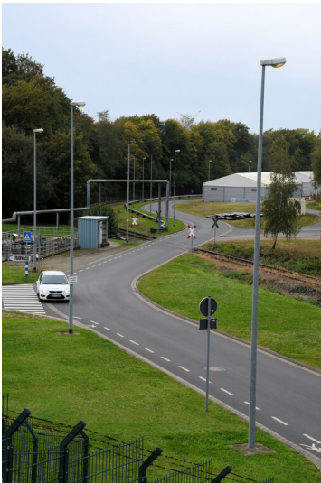
Kraftwerk Neurath: Kiesgrubenstraße, von der Altanlage kommend kurz vor Erreichen der Neuanlage, Ansicht von Nordosten; Foto: 23.10.2023 Fotograf/Urheber: Dr. Norbert Gilson
