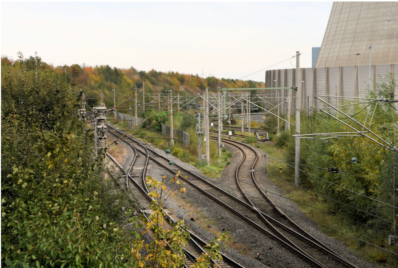
Kraftwerk Neurath: Anschlussgleise Blöcke A/E vor Einfahrt in das Kraftwerksgelände der Altanlage, Ansicht von Westen; Foto: 23.10.2023 Fotograf/Urheber: Dr. Norbert Gilson
