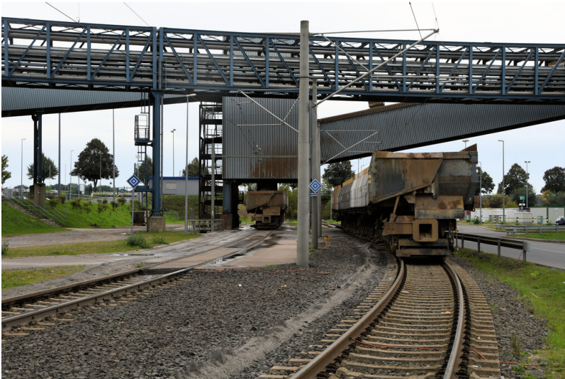
Kraftwerk Neurath (Neuanlage): Aschegleise Blöcke F/G, Ansicht von Nordosten; Foto: 23.10.2023 Fotograf/Urheber: Dr. Norbert Gilson
