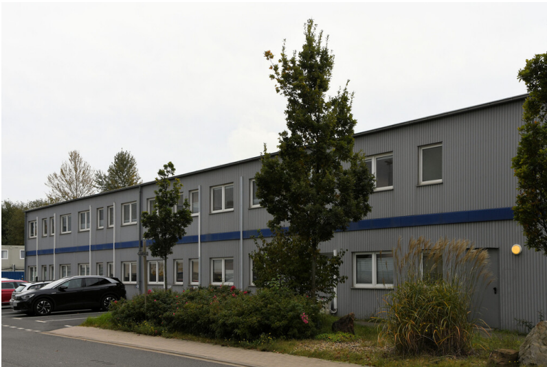
Kraftwerk Neurath: Gebäude der Bauleitung, nördlicher Seitenflügel, Ansicht von Nordwesten; Foto: 23.10.2023 Fotograf/Urheber: Dr. Norbert Gilson
