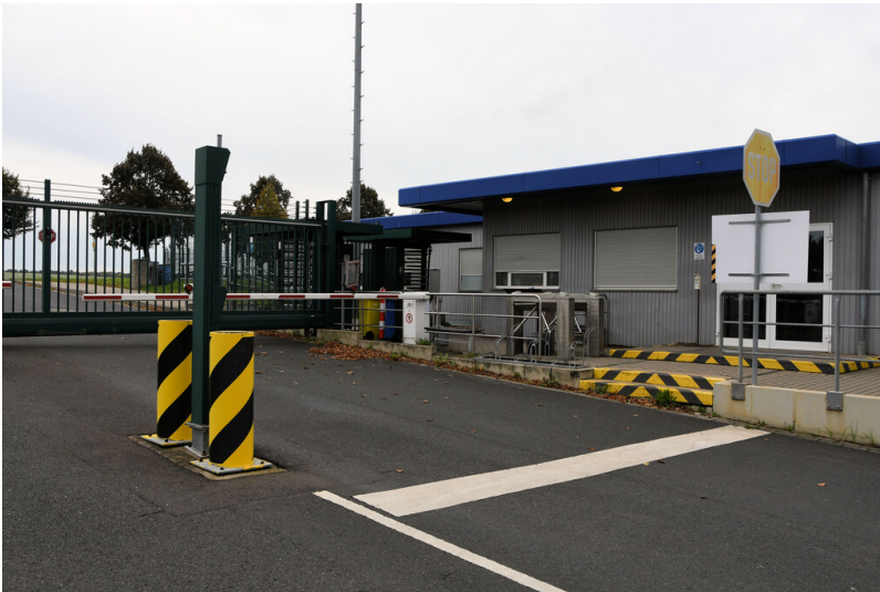
Kraftwerk Neurath: Pförtner Tor 1, Bereich der Zugangskontrolle, Ansicht von Nordosten; Foto: 23.10.2023 Fotograf/Urheber: Dr. Norbert Gilson
