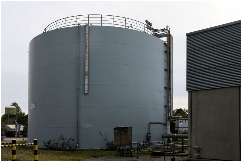
Kraftwerk Neurath: Heizöltank, Ansicht von Norden; Foto: 23.10.2023 Fotograf/Urheber: Dr. Norbert Gilson
