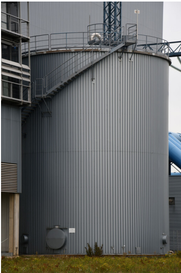
Kraftwerk Neurath: Kalkkondensatspeicher für Block G, Ansicht von Westen; Foto: 23.10.2023 Fotograf/Urheber: Dr. Norbert Gilson
