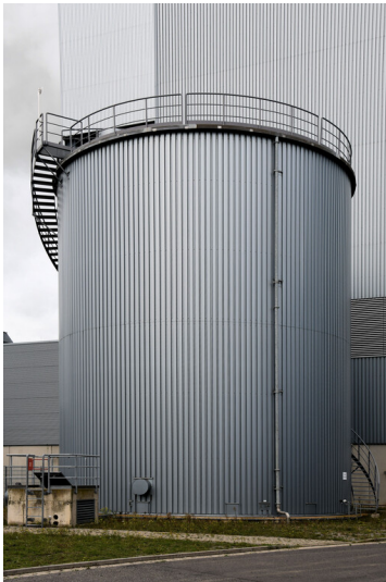
Kraftwerk Neurath: Kalkkondensatspeicher für Block F, Ansicht von Süden; Foto: 23.10.2023 Fotograf/Urheber: Dr. Norbert Gilson
