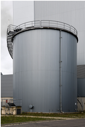
Kraftwerk Neurath: Kalkkondensatspeicher für Block F, Ansicht von Süden; Foto: 23.10.2023 Fotograf/Urheber: Dr. Norbert Gilson
