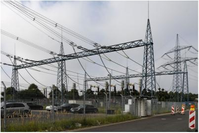
Kraftwerk Neurath: Freiluft-Schaltanlage Blöcke F/G, Abgang der Leitungsseile (Viererbündel) als 380-kV-Leitungen "Neurath 4d" und "Neurath 5e". Ansicht von Nordosten; Foto: 14.09.2023 Fotograf/Urheber: Dr. Norbert Gilson
