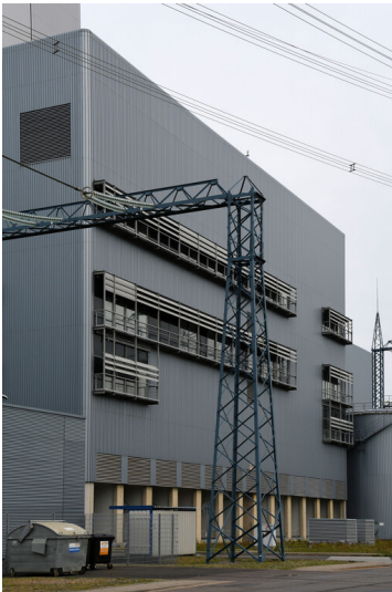
Kraftwerk Neurath (Neuanlage): Hauptschaltanlage, Ansicht von Südwesten; Foto: 23.10.2023 Fotograf/Urheber: Dr. Norbert Gilson
