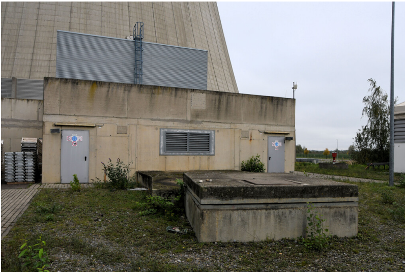
Kraftwerk Neurath (Neuanlage): Kühlwasser-Pumpenhaus Block G, Ansicht von Süden; Foto: 23.10.2023 Fotograf/Urheber: Dr. Norbert Gilson
