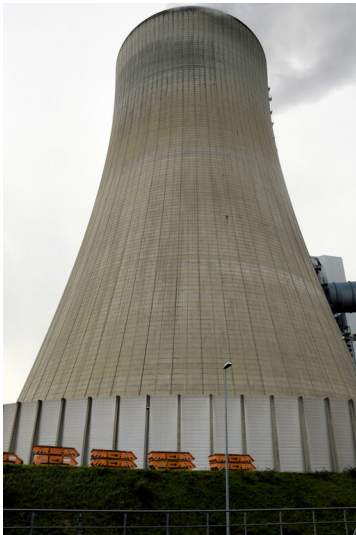
Kraftwerk Neurath (Neuanlage): Naturzug-Kühlturm Block G, Schallschutzwand an der Kühlturmbasis, Ansicht von Westen; Foto: 23.10.2023 Fotograf/Urheber: Dr. Norbert Gilson
