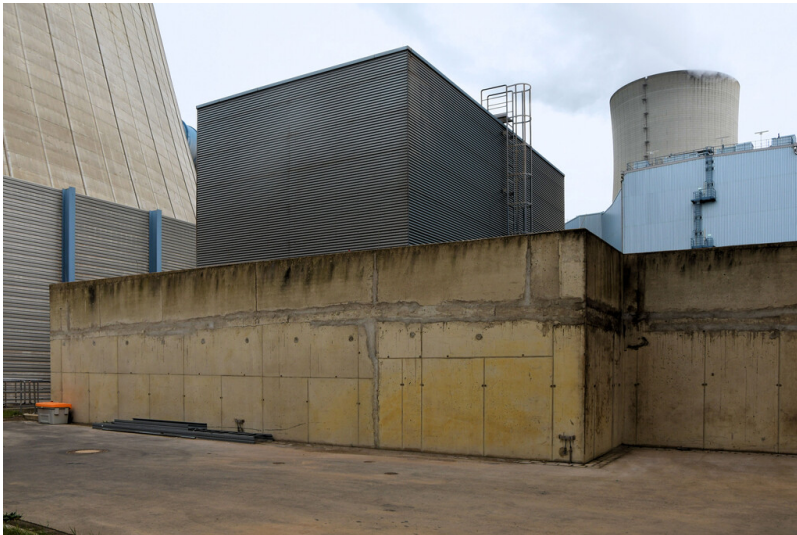
Kraftwerk Neurath (Neuanlage): Kühlwasser-Pumpenhaus Block F, Ansicht von Westen; Foto: 23.10.2023 Fotograf/Urheber: Dr. Norbert Gilson
