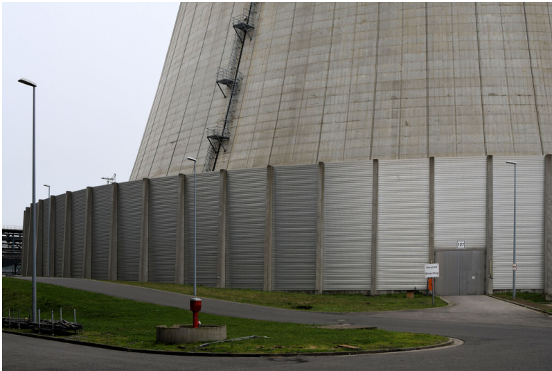
Kraftwerk Neurath (Neuanlage): Naturzug-Kühlturm Block F, Schallschutzwand, Ansicht von Nordosten; Foto: 23.10.2023 Fotograf/Urheber: Dr. Norbert Gilson
