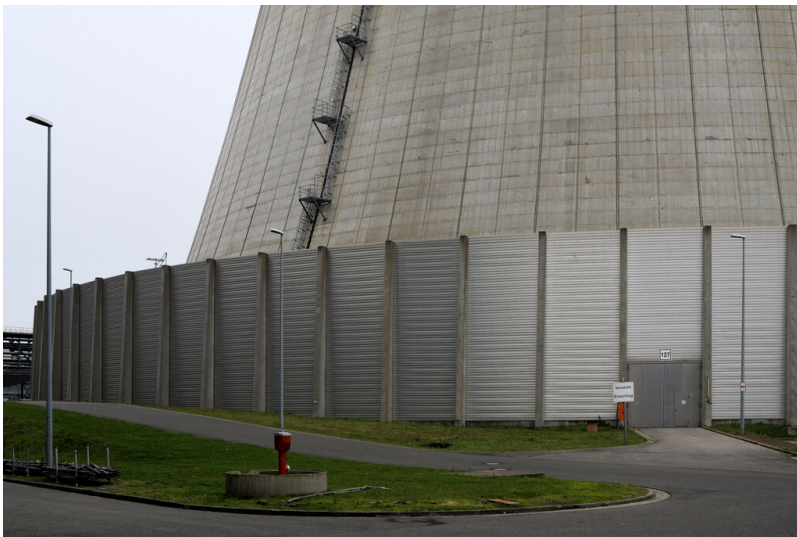
Kraftwerk Neurath (Neuanlage): Naturzug-Kühlturm Block F, Schallschutzwand, Ansicht von Nordosten; Foto: 23.10.2023 Fotograf/Urheber: Dr. Norbert Gilson
