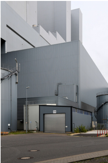
Kraftwerk Neurath: Maschinenhaus Block F, Ansicht von Südwesten; Foto: 23.10.2023 Fotograf/Urheber: Dr. Norbert Gilson
