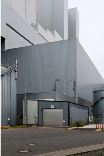
Kraftwerk Neurath: Maschinenhaus Block F, Ansicht von Südwesten; Foto: 23.10.2023 Fotograf/Urheber: Dr. Norbert Gilson
